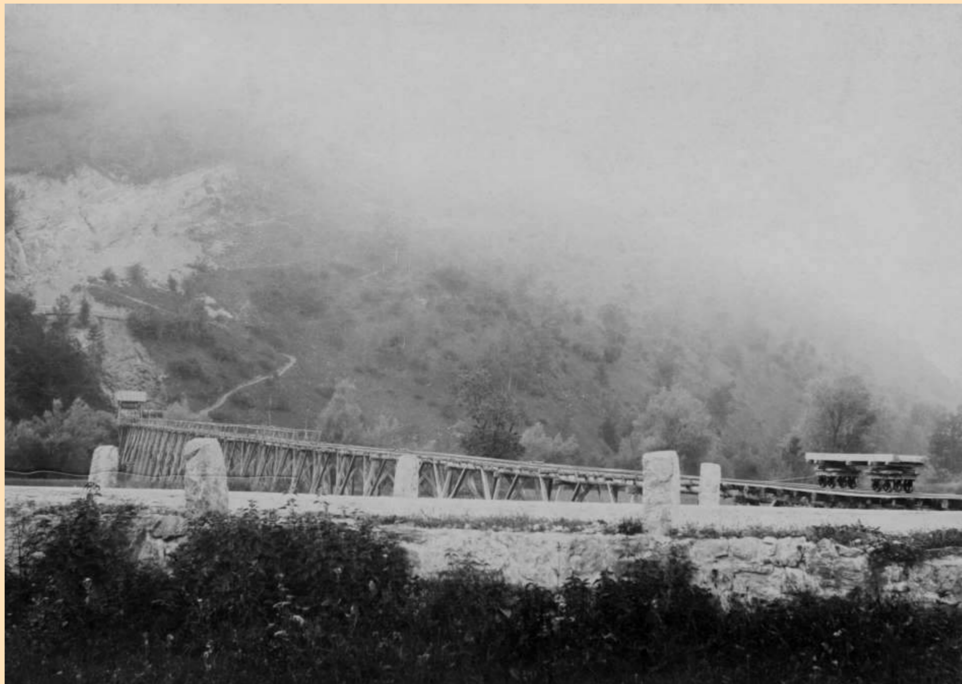
Železniška proga, po kateri so vozili kamenje iz kamnoloma v Žirku do gradbišča nove cerkve, fotografirana verjetno okrog 1907. The «railway» used to transport stone to the building site of the new church in Žiri, around 1907.
