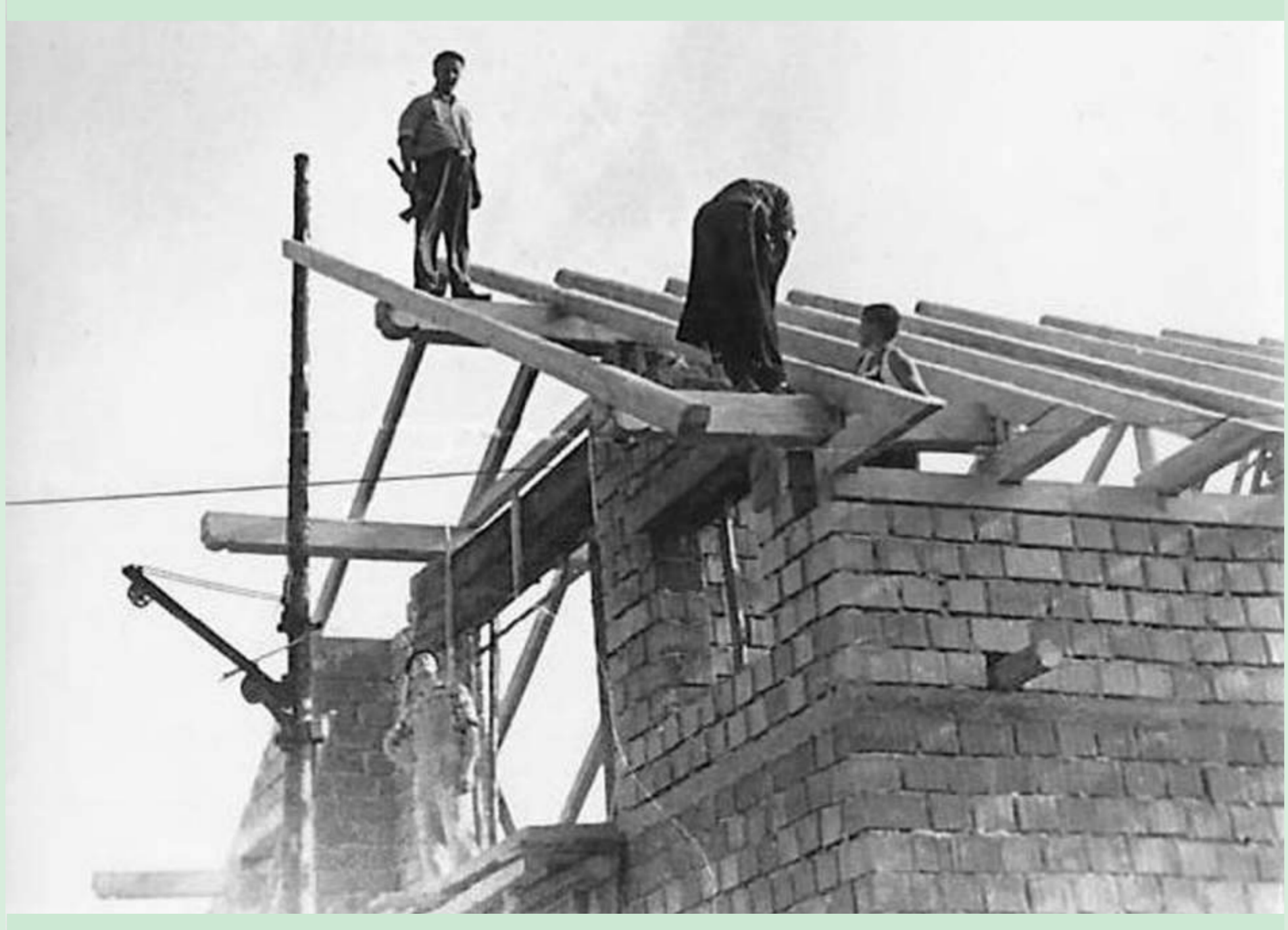
Na vrhu ostrejša nove hiše Milana Gantarja stoji Vili Gregorač, Bedrihar je sklonjen pod njim, desno do njega gleda iz rušta »investitor« Milan Gantar, na balkonu stoji Tone Bačnar. On the rooftop of a new house.
