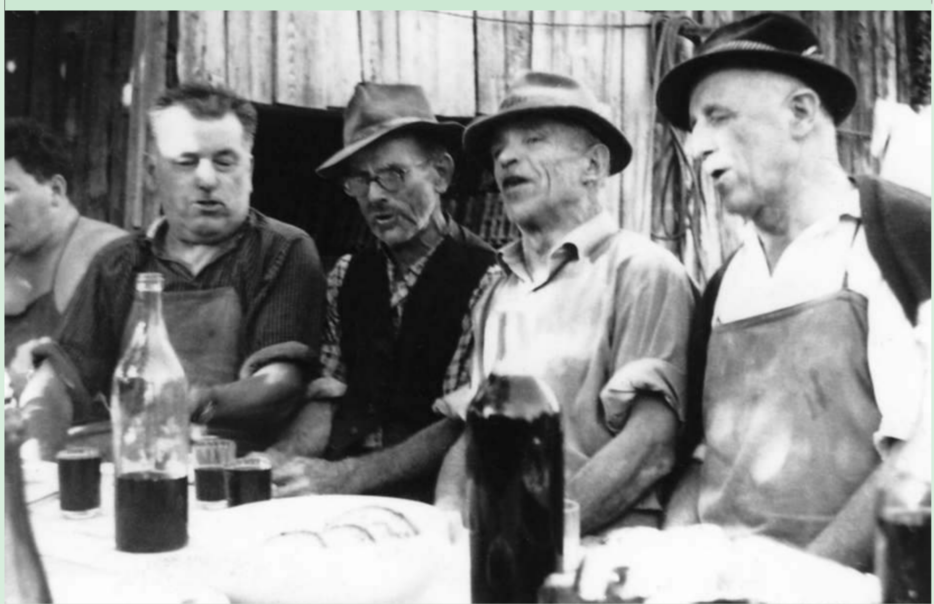
Po plati je bila zmeraj še »betonska veselica«. Na sliki pojo (z leve): Rado in Jakob Kristan, Štefan Oblak - Jožetov, Franc Miklavčič – Štrajtov in Andrej Naglič - Kijun. Na gradbišču nove hiše Anice Eisele, Selo, 30. avgust 1969. After the plate was laid, there was always »concrete merrymaking«.
