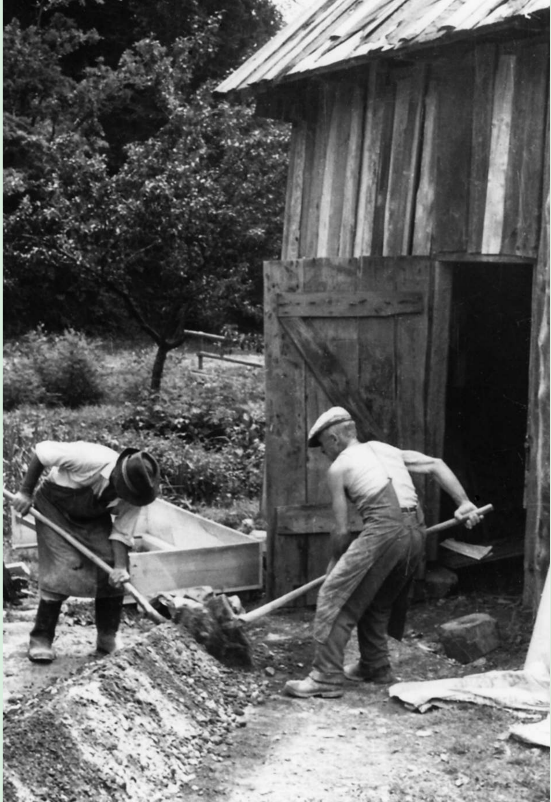
Tako se je mešalo beton, mešalca sta Jakob Žakelj – Črvov in Franc Miklavčič – Štrajtov. Na Selu, pri gradnji hiše Tončke Cankar, 19. julij 1959. This is how concrete was mixed.
